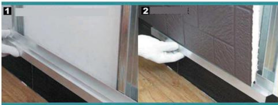
Pose sur cornières alu
